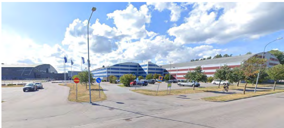
Nuläge vid entréområdet, parkering och zon för drop-off vid idrottsanläggningen. (bild från Google)
