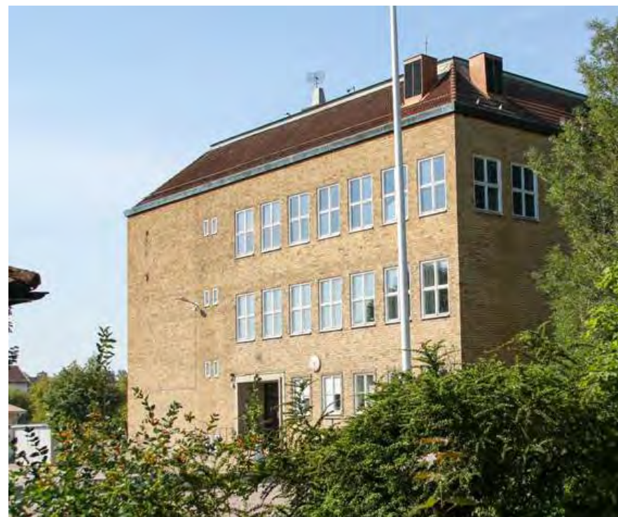
Befintlig tegelbyggnad. Släbroskolan, Nyköpings kommun
